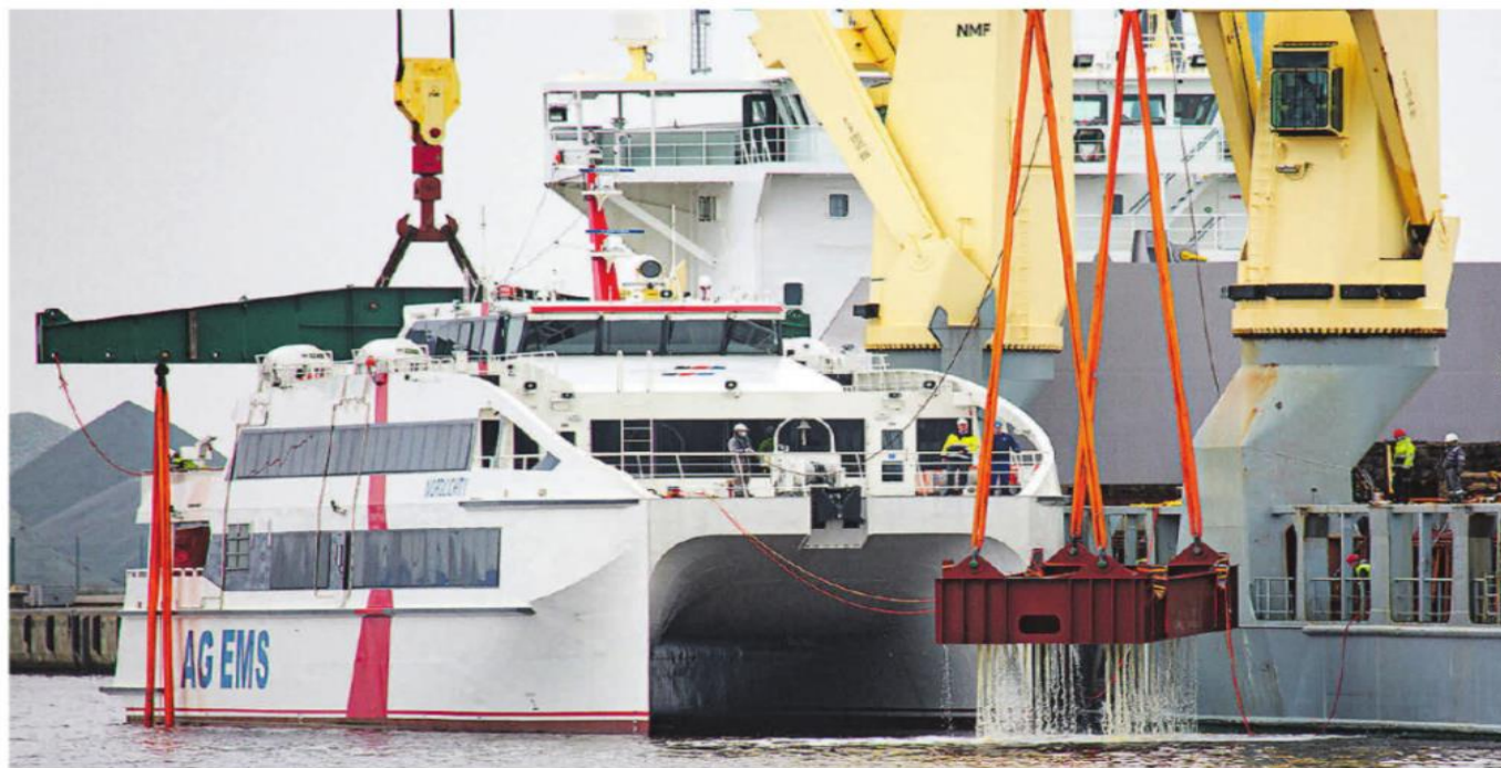
Gurte und Stahlträger werden entfernt, Die „Nordlicht II“ schwimmt im Neuen Binnenhafen.
